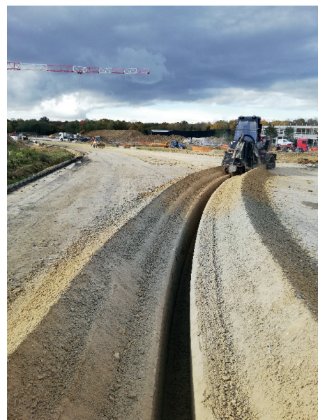
Trancheuse TORO 1200 Q déportable de droite à gauche 20 cm de large 100 cm en profondeur
