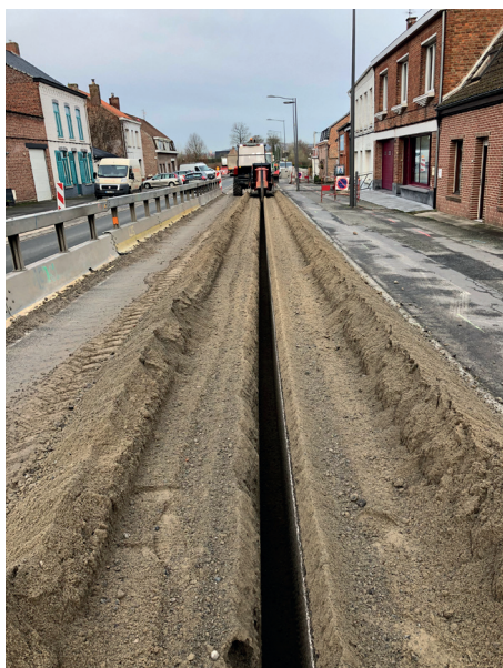
Trancheuse DW RT 125 déportable de droite à gauche 15 cm de large 100 cm en profondeur
